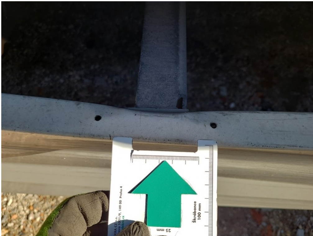
Viz popis k poškození č. 2
