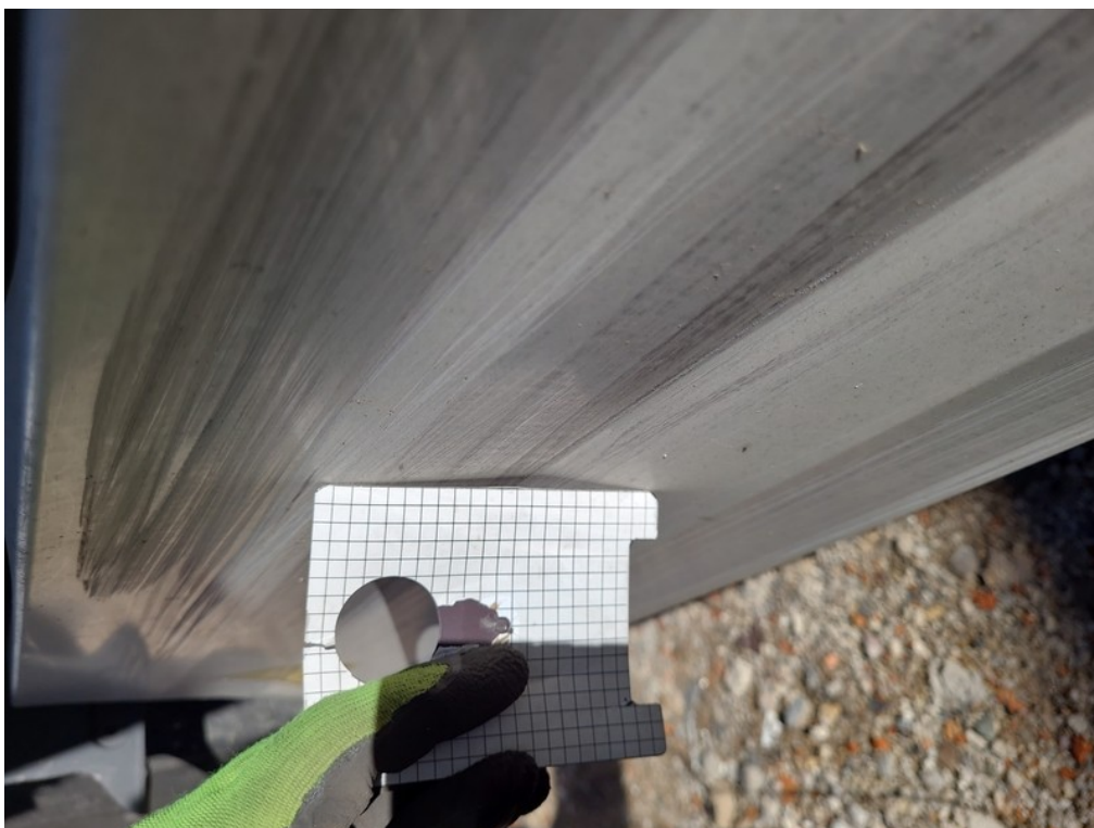
Viz popis k poškození č. 2
