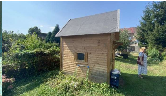
Dřevěná chatka bez základů
