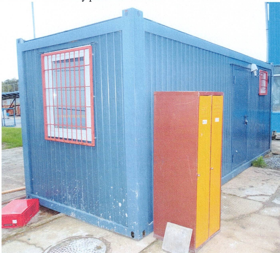
Obrázek č.5: celkový pohled na zařízení
