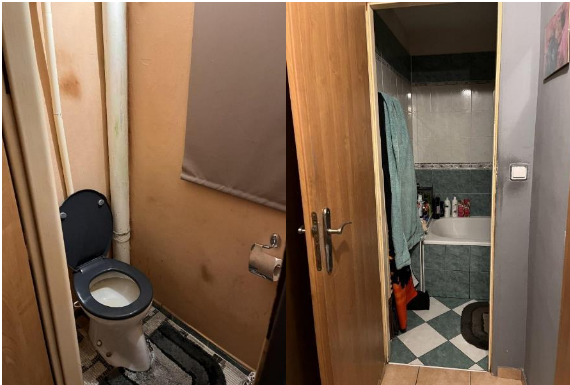
Bytová jednotka č. 446/1 - WC
