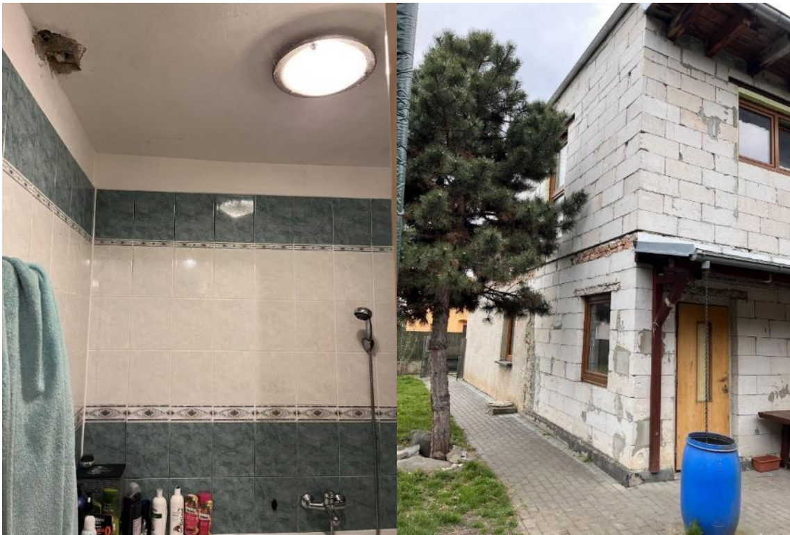
Rozestavěná bytová jednotka - vchod
