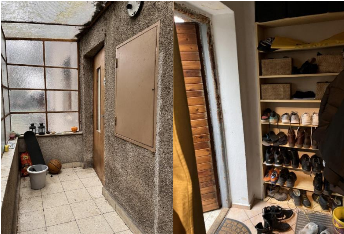
Bytová jednotka č. 446/1 - vchod
