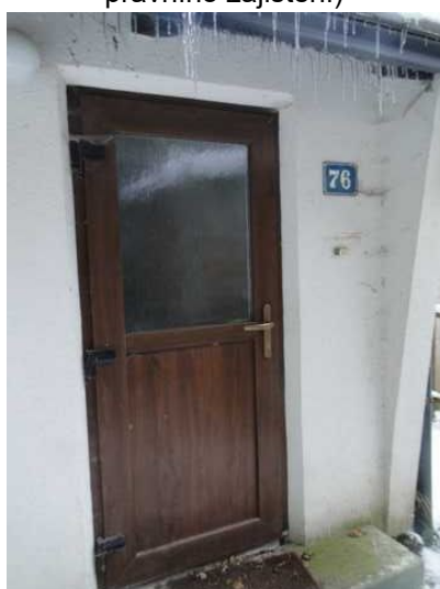
Vstup do RD s označením č.p.
