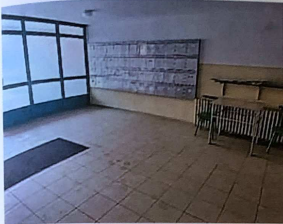
Vstupní chodba v domě
