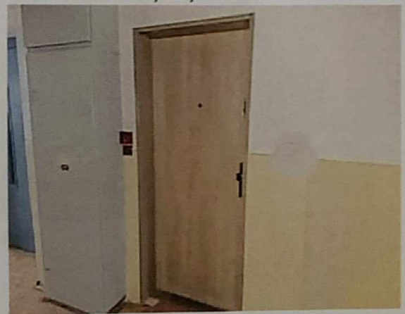
Vstup do bytu
