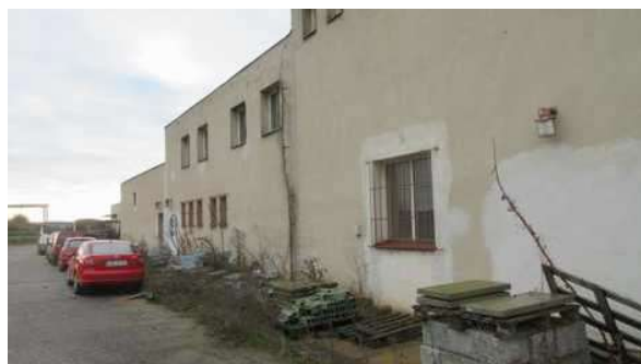
Provozní hala č.p. 389 v k.ú. Předměřice nad Labem
