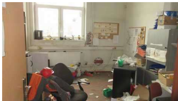
Interiér budovy v 1.NP
