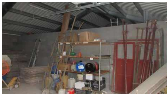
Interiér skladovací haly
