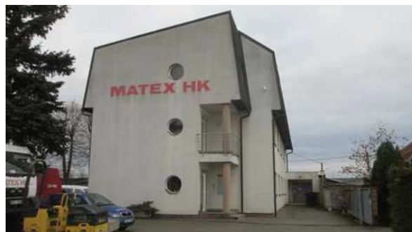
Administrativní budova č.p. 181 v k.ú. Slezské Předměstí
