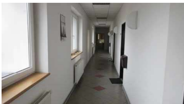
Chodba ve 3.NP
