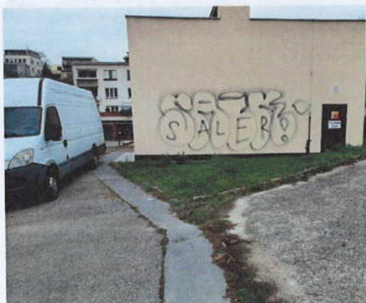
Pozemek parc.č. 951/6 (obklopující trafostanici) - jihovýchodní část souboru pozemků
