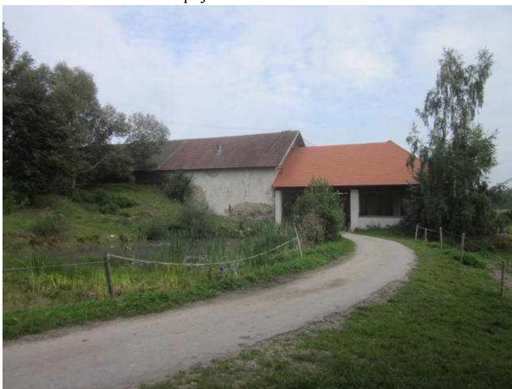
jižní křídlo usedlosti od příjezdu
